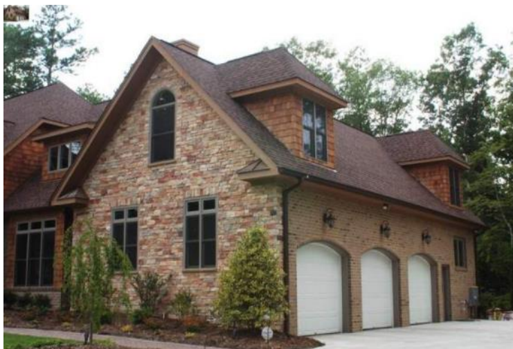
Рис.2 Оздоблення фасаду будівлі натуральним каменем
