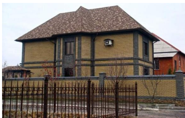
Рис.1 Оздоблення фасаду будівлі клінкерною плиткою
