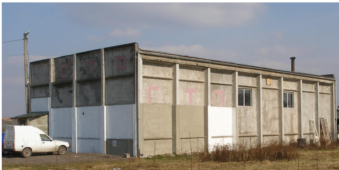
Рисунок 2. Вигляд на фасади будівлі по осям «9» та «Б»
