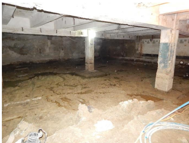
Рисунок 4. Фрагмент підвалу в осях «4-6/Б-В»
