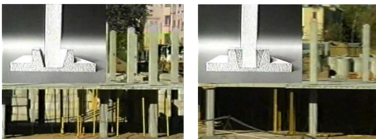
Рис.6. Вигляд першого і другіх поверхів в процесі монтажу.
