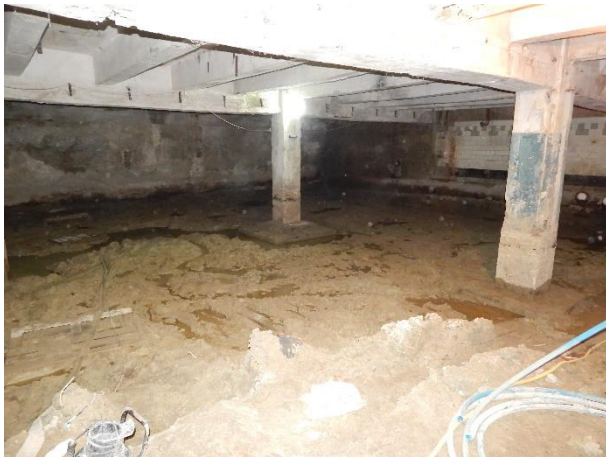
Рисунок 4. Фрагмент підвалу в осях «4-6/Б-В»
