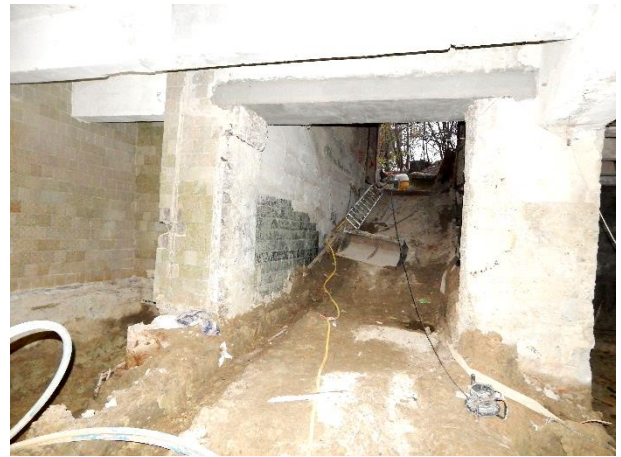
Рисунок 5. Вихід з підвалу в осях «3-4» по осі «Г»
