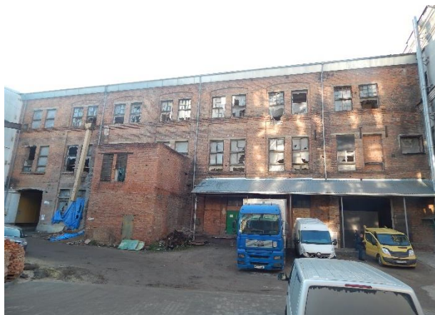
Рисунок 1. Фасад існуючої будівлі по осі «Б»
