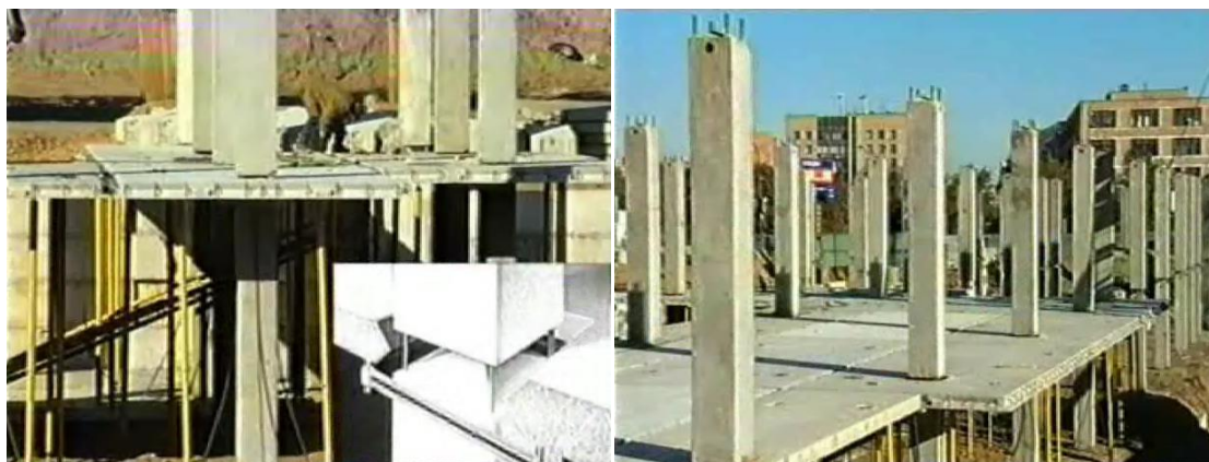
Рис.13. Вигляд консольних частин будинку в процесі монтажу і кріплення елементів каркасу.
