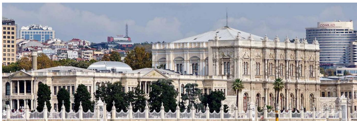
Рис. 3. Палац Долмабахче. Загальний зовнішній вигляд
