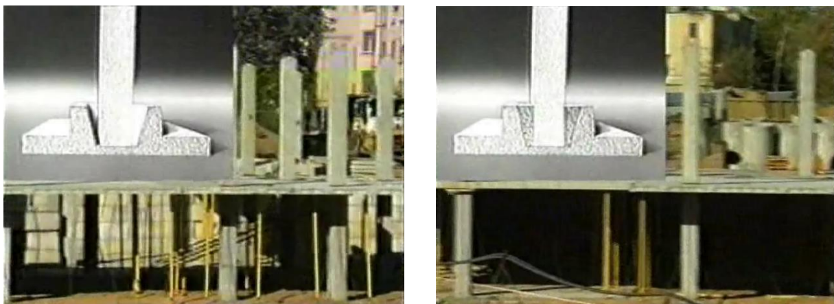
Рис.6. Вигляд першого і другіггг поверхів в процесі монтажу.
