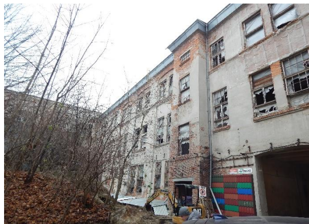
Рисунок 2. Фасад існуючої будівлі по осі «Д»
