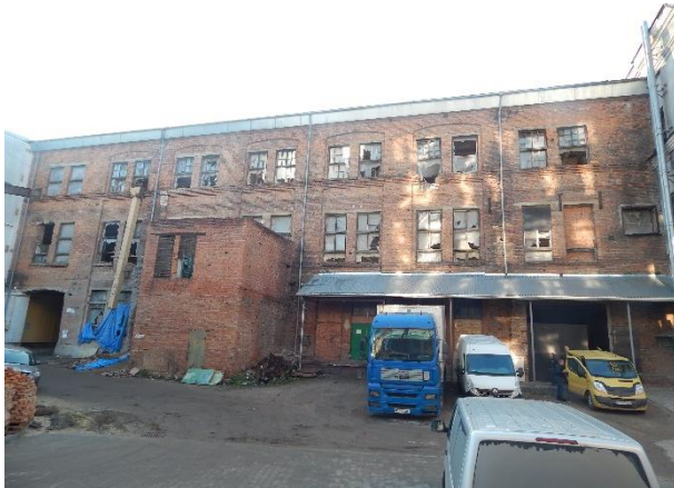
Рисунок 1. Фасад існуючої будівлі по осі «Б»
