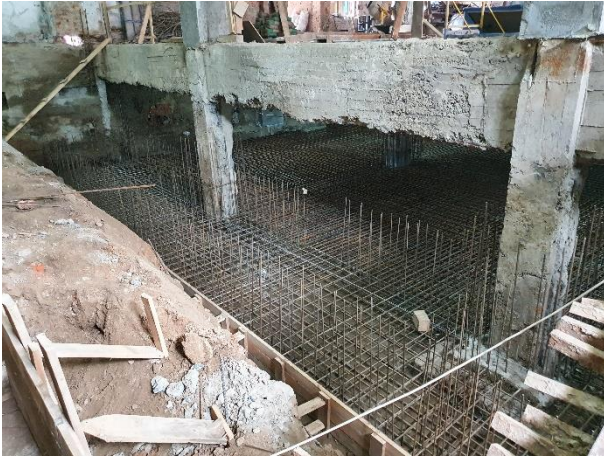
Рисунок 12. В процесі виконання робіт по улаштуванню фундаментної плити
