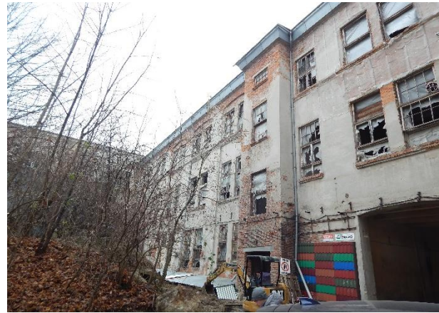
Рисунок 2. Фасад існуючої будівлі по осі «Д»
