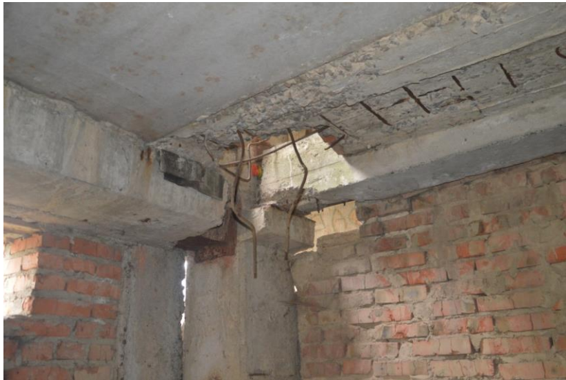
Фігура 3. Стик ригелів із колоною. Руйнування опорою зони. Руйнування перекриття
