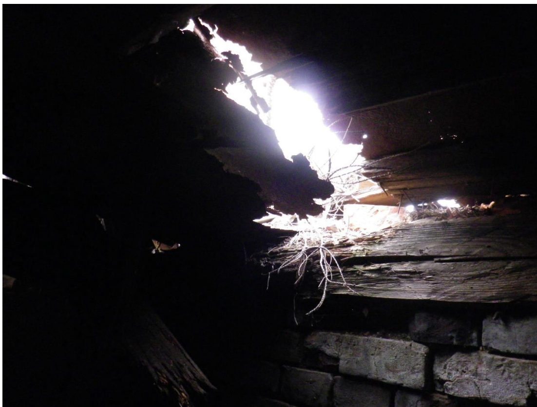
Фігура 13. Руйнування кладки підпірних парапетних стін. Руйнування мауерлату. Руйнування кроквяних ніг.
