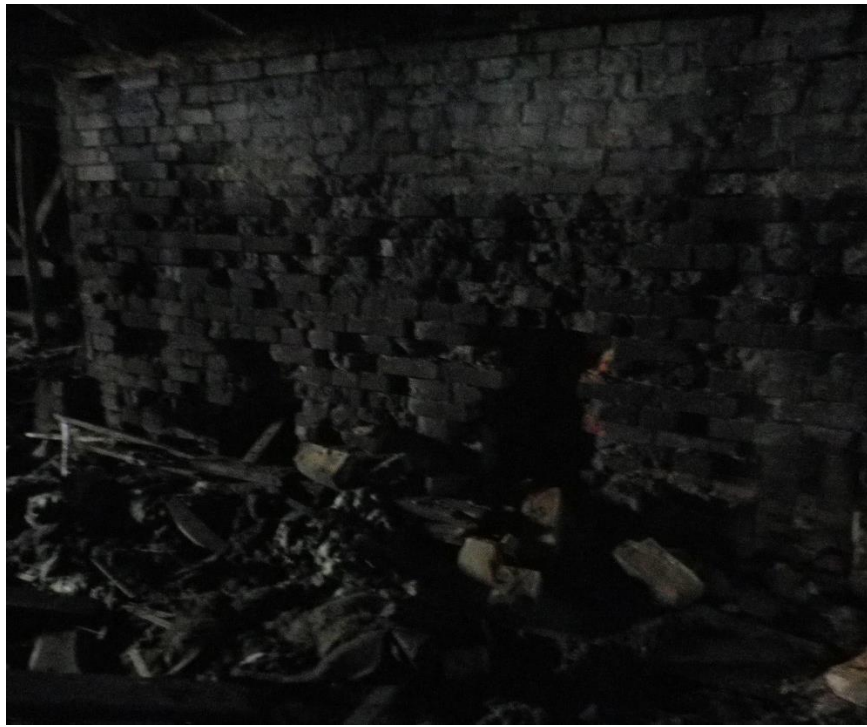
Фігура 2 Руйнування стін підвалу. (Механічні причини)
