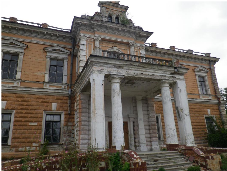
Фігура 5. Загальний стан головного фасаду будівлі
