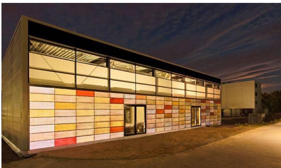
Мал. 6. Застосування склобетону при оформленні фасаду.
