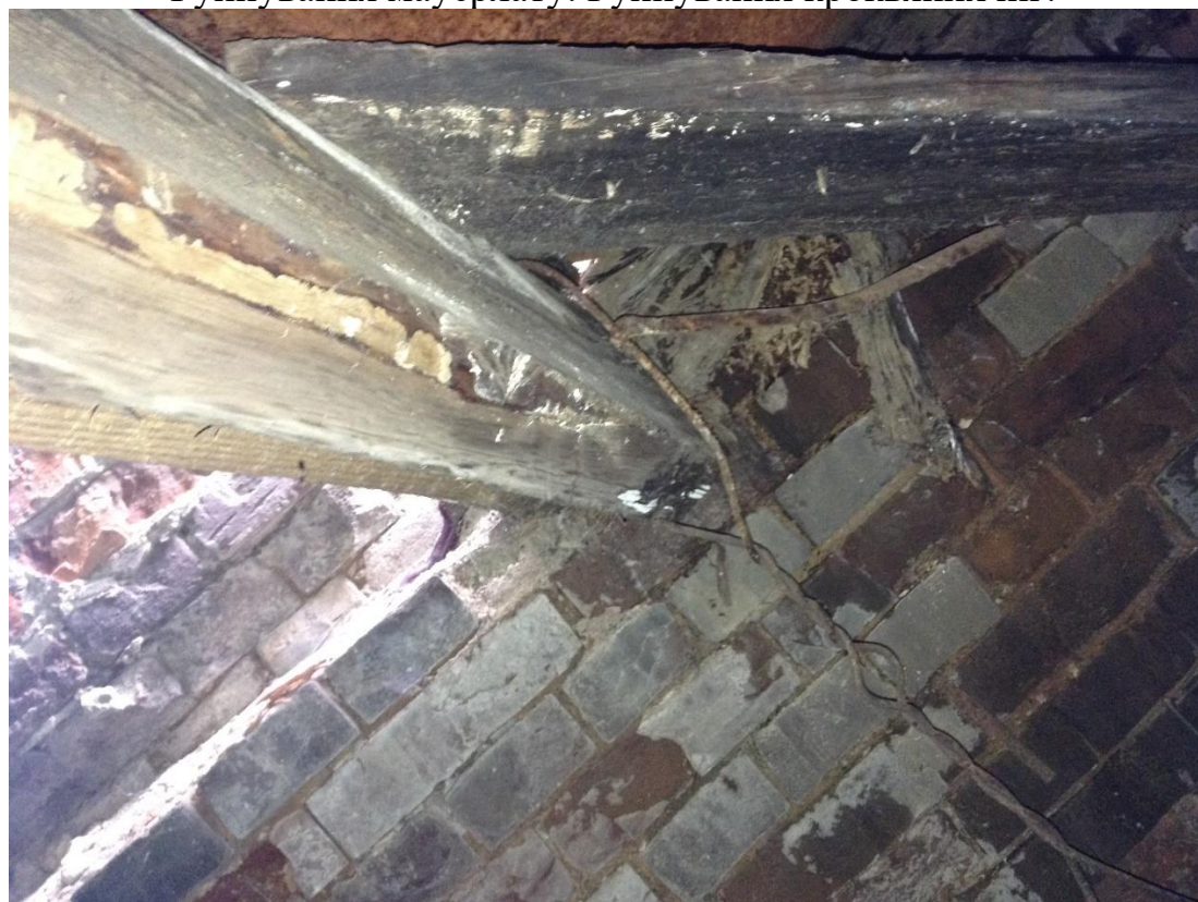
Фігура 14. Руйнування мауерлату. Руйнування кроквяних ніг.
