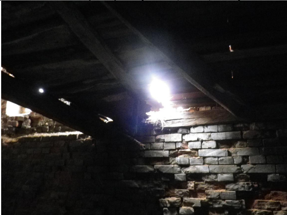
Фігура 12. Відсутність покрівлі. Руйнування кладки підпірних парапетних стін. Руйнування мауерлату. Руйнування кроквяних ніг.
