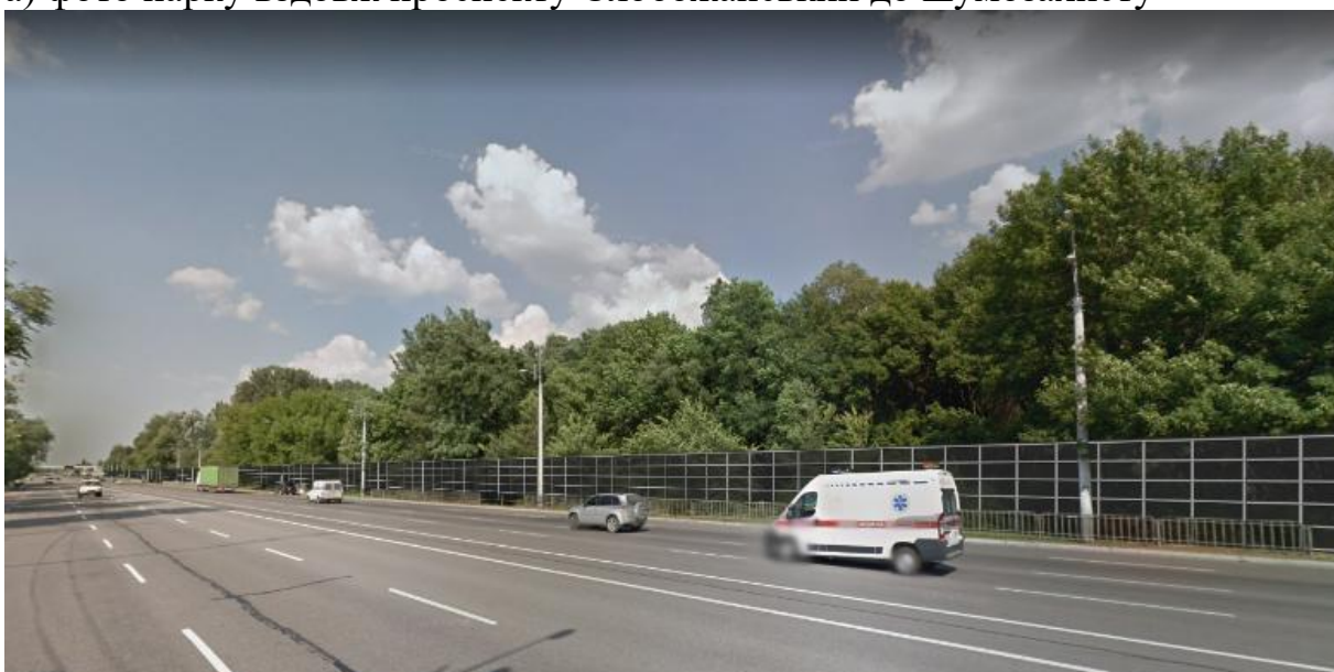
б) а) фото парку вздовж проспекту Слобожанський після шумозахисту (висота екрану 3,0 метри)
