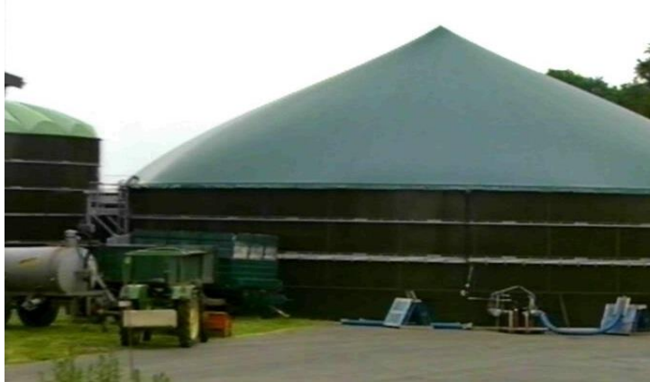
Рис. 4. Зовнішній вигляд біогазової установки
