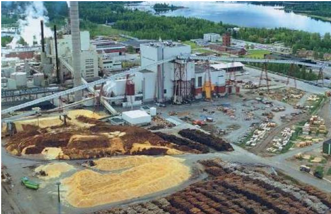
Рис. 5. Паливний майданчик ТЕЦ «Albolmens Kraft-2» (Фінляндія), що працює на відходах деревообробної промисловості
