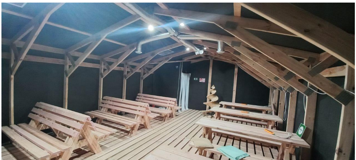
Рис. 2. Модуль з несучими рамами і вузлами на зубчастих пластинах
