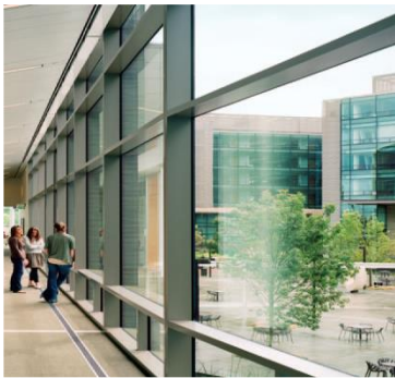
4 - фасадне скління має коефіцієнт теплопровідності 0,32 Вт/(м•°C), що значно перевищує вимоги нормативних документів у Сіетлі. Крім цього, при виборі матеріалів скління враховувалася необхідність максимальної забезпеченості приміщень природним освітленням.
