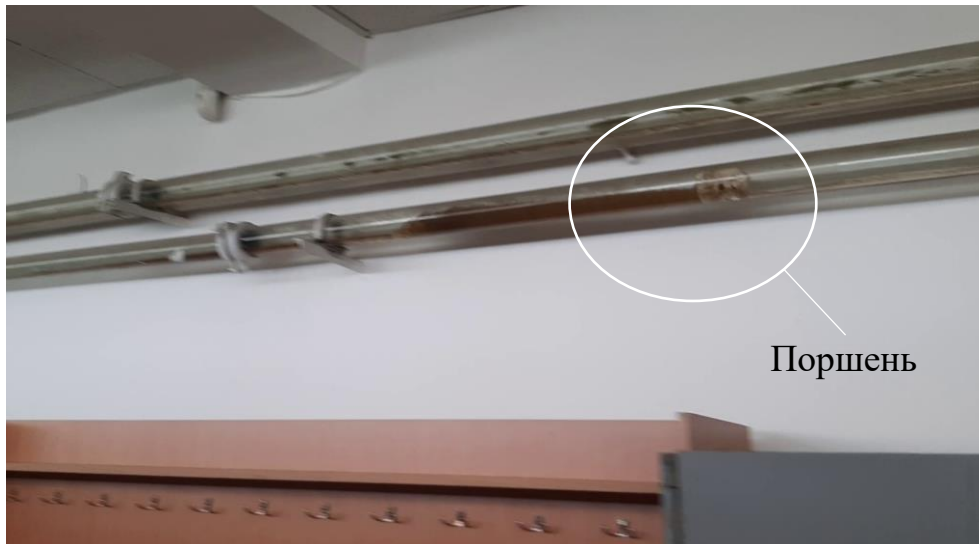
Рисунок 2. Очищення трубопроводу поршнем із гіперпружного матеріалу
