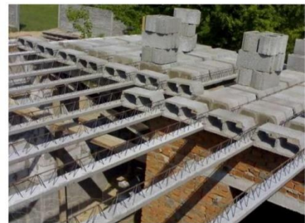
збірно-монолітне перекриття
