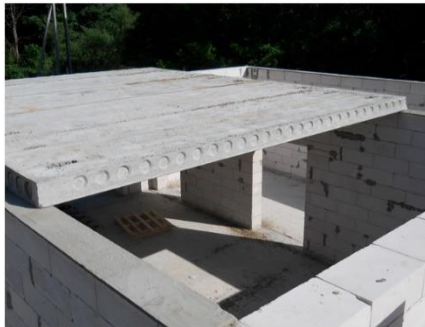
збірне перекриття
