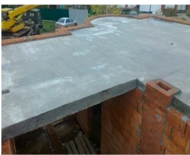
монолітне перекриття
