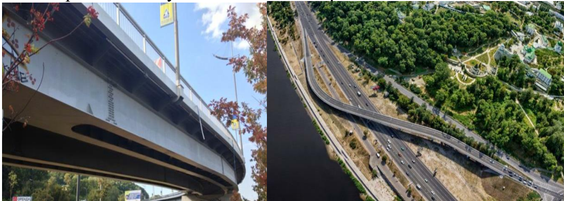
Естакада Дніпровського спуску (з атмосферостійкої сталі), Київ
