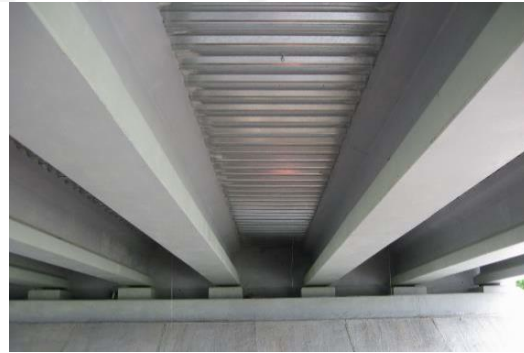
Міст в с. Луки, Львівська обл. (застосування профілю Т57 як незнімної опалубки)
