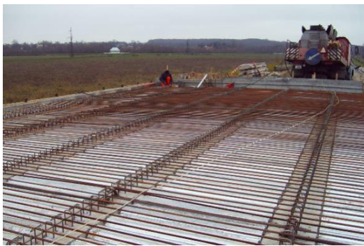
Міст в с. Луки, Львівська обл. (застосування профілю Т57 як незнімної опалубки)
