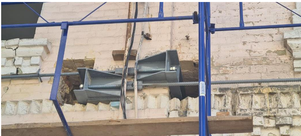
Рисунок 3. Вузол з'єднання тяжів та балок підсилення
