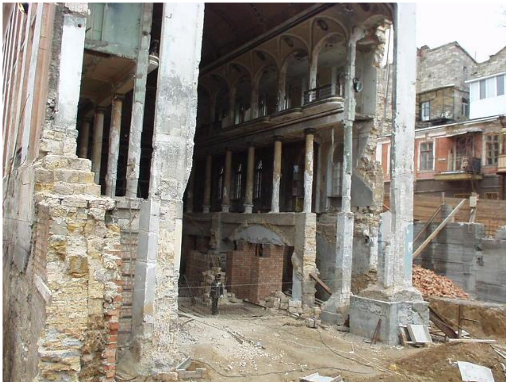
Рис. 1. Технічний стан будівлі до реконструкції
