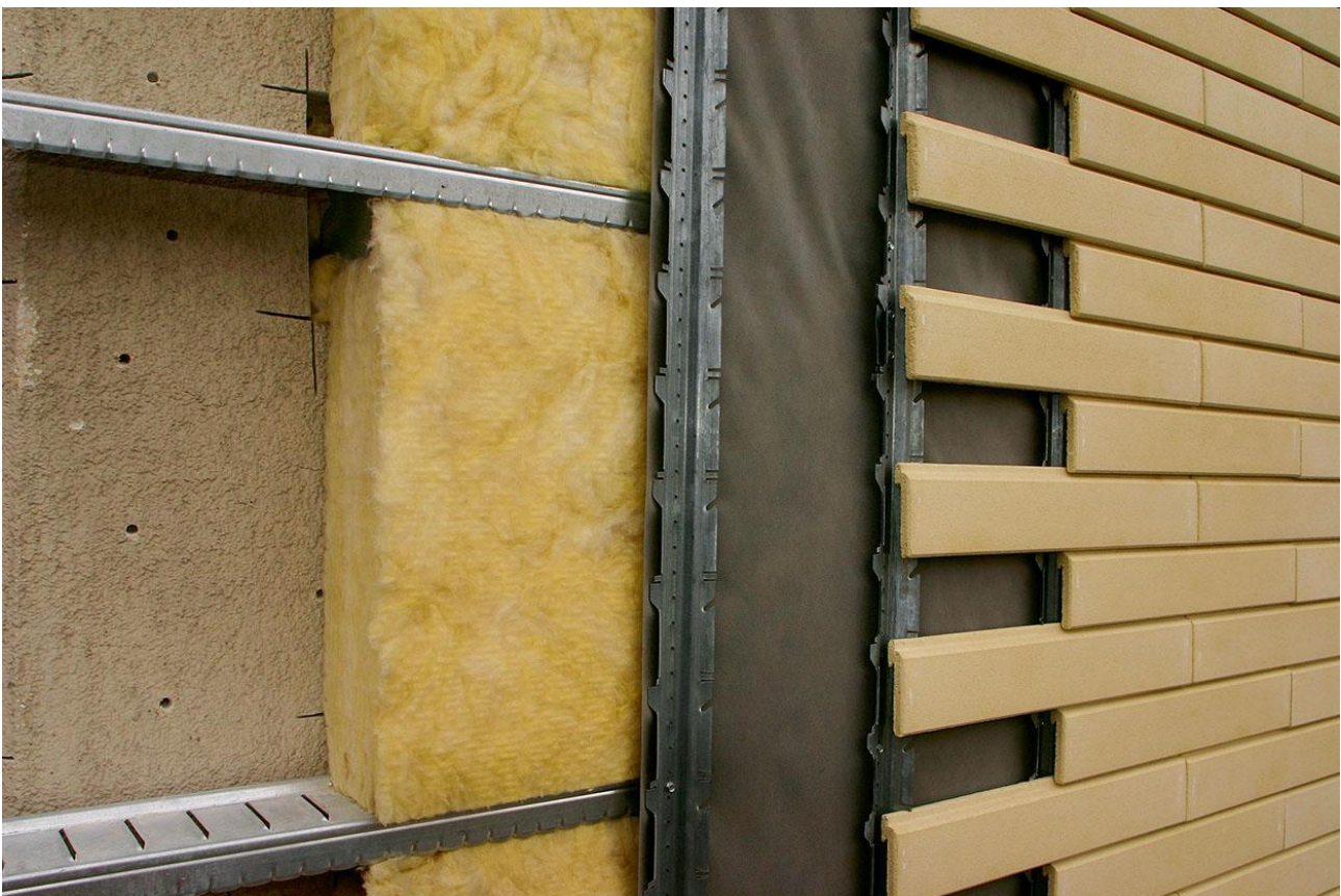
Рисунок 2 Утеплення стіни під подальше облицювання цеглою
