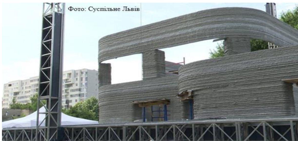
Рис.1. Стіни початкової школи у м. Львів, зведені за допомогою технології 3D-друкованого будівництва
