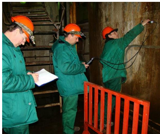
Рисунок 2 – Виконання ультразвукової діагностики бетону в приповерхневому шарі турбінного приміщення
