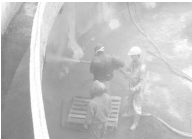
Рисунок 6. Підсилення оболонки резервуару з внутрішньої поверхні торкретуванням
