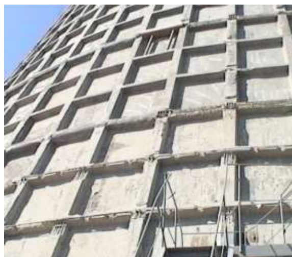
Рисунок 3. Підсилення оболонки збірної градирні стяжними арматурними стрижнями
