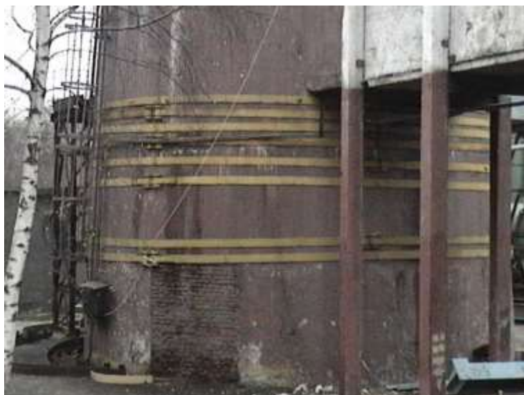
Рисунок 1. Підсилення оболонок стяжними сталевими стрічками: а – оболонок силосів; б – оболонки димової труби
