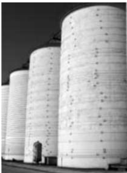
Рисунок 1. Підсилення оболонок стяжними сталевими стрічками: а – оболонок силосів; б – оболонки димової труби
