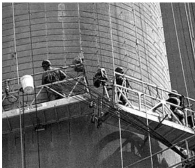
Рисунок 5. Підсилення оболонки силосу горизонтальними вуглецевими композитними стрижнями
