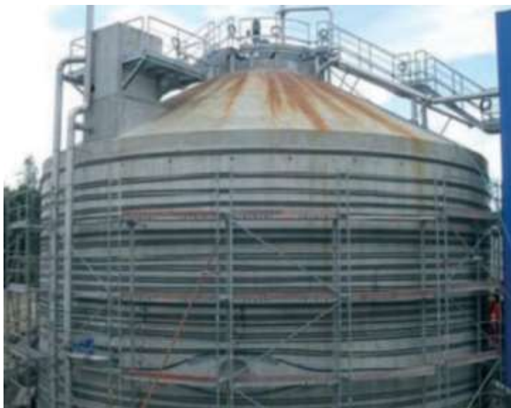
Рисунок 2. Підсилення оболонки резервуару стяжними сталевими тросами
