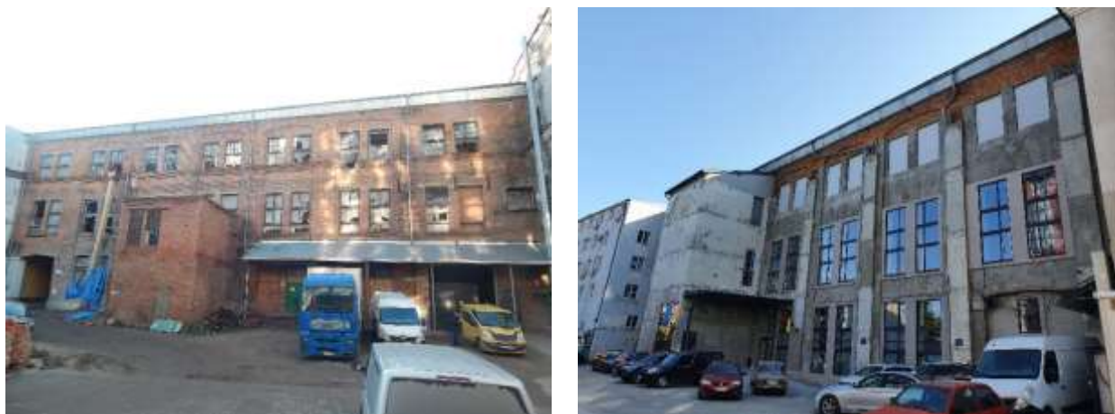
а б Рисунок 4. Загальний вигляд виробничої будівлі: а – до реконструкції; б – в процесі реконструкції
