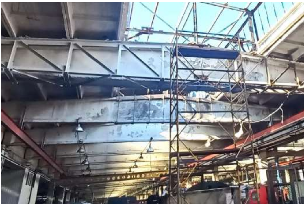
Рис. 3. Реалізація конструктивного рішення підсилення
